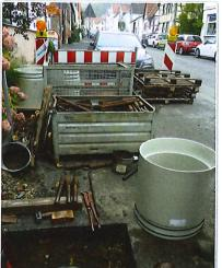
v.l.n.r./left to right: Die Kurzrohre werden in die Startgrube eingebracht. Der Rohrvortrieb erfolgt mittels Hydraulikpresseinheit. Der Kanalverlauf entlang der Wohnbebauung erlaubt keine Erneuerung in offener Bauweise. The short pipes are introduced into the jacking trench. Pipe jacking using hydraulic press unit. The sewer route along a housing development meant that open-trench renewal was not possible.
