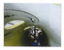
Korrekte Platzierung des Innensattel mittels Roboter und Kameraüberwachung. Verschweißter Innensattel (Vorversuche bei Firma karo-san).
